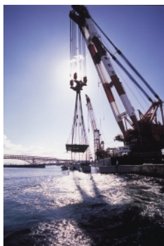
西川 清 「ケーソン据付け現場」(大阪府大阪港)
