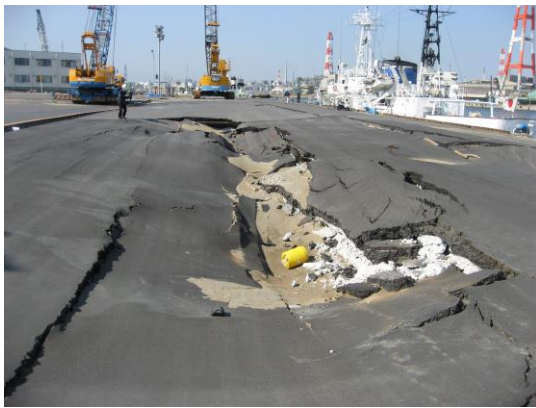
沼地を埋め立てて築造したため被害が甚大
