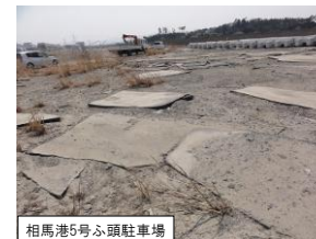
相馬港5号ふ頭駐車場
