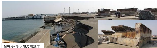
相馬港2号ふ頭先端護岸
