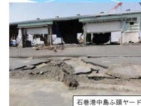
石巻港中島ふ頭ヤード
