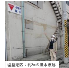
塩釜港区：約3mの浸水痕跡
