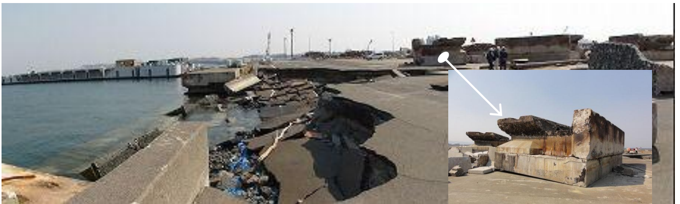
ph-So07 2号埠頭先端護岸(同被災ブロック)
