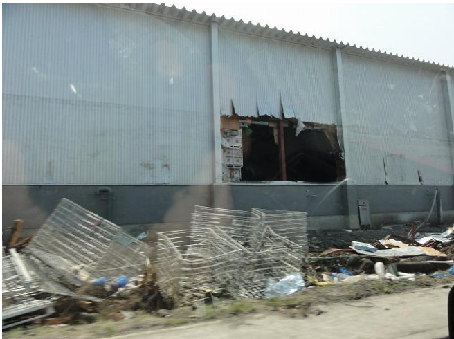
ph-Oo09 津波が建屋内の空隙を貫通
