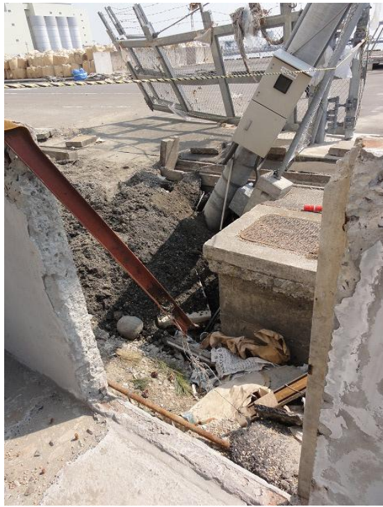
ph-Se07 保安ゲート・フェンス
