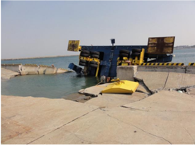
ph-So08 2号ふ頭岸壁(-7.5)
