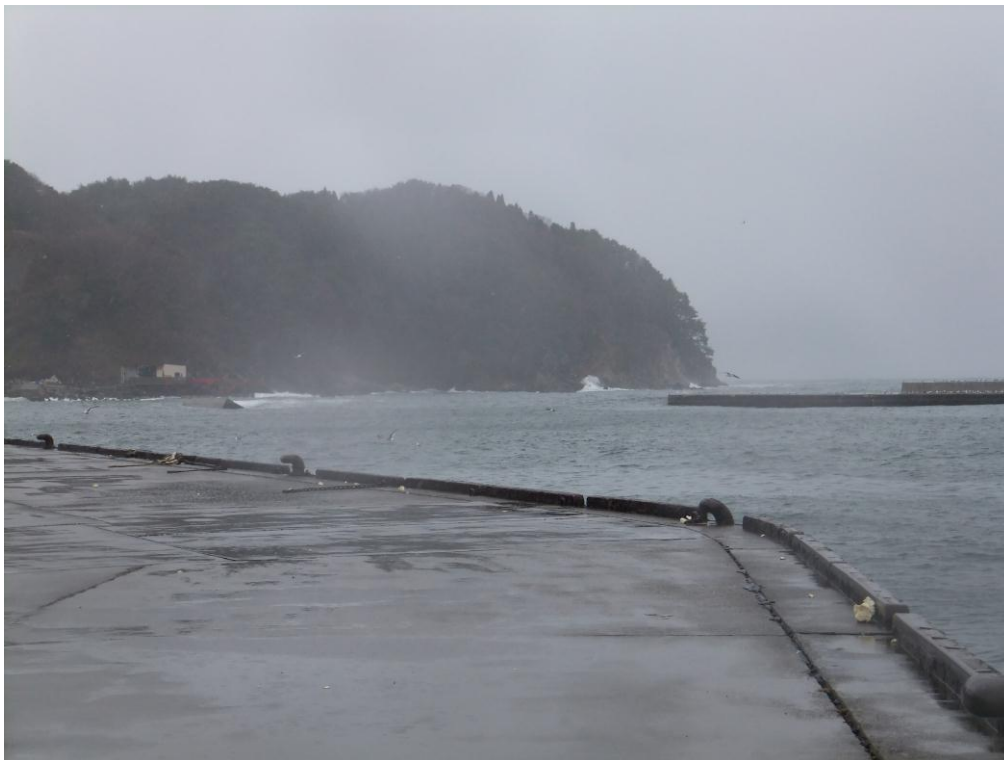
出崎地区（出崎防波堤）
