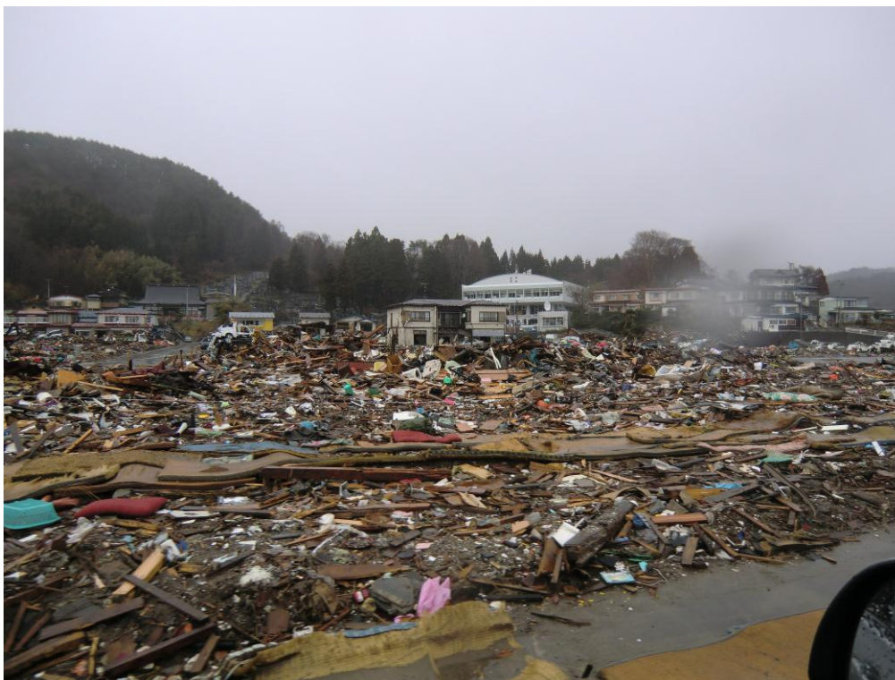
宮古から三沢へ向かう途中の田老地区の被災状況
