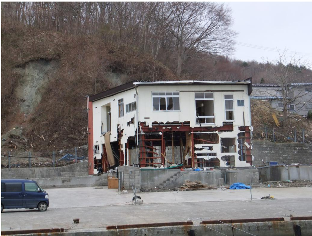
津波により破壊された建物（玉の脇地区）
