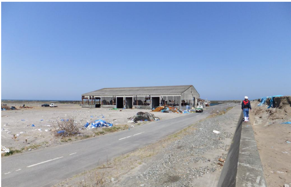
市川地区 津波で破壊された工場(浸水高 8.4m)
