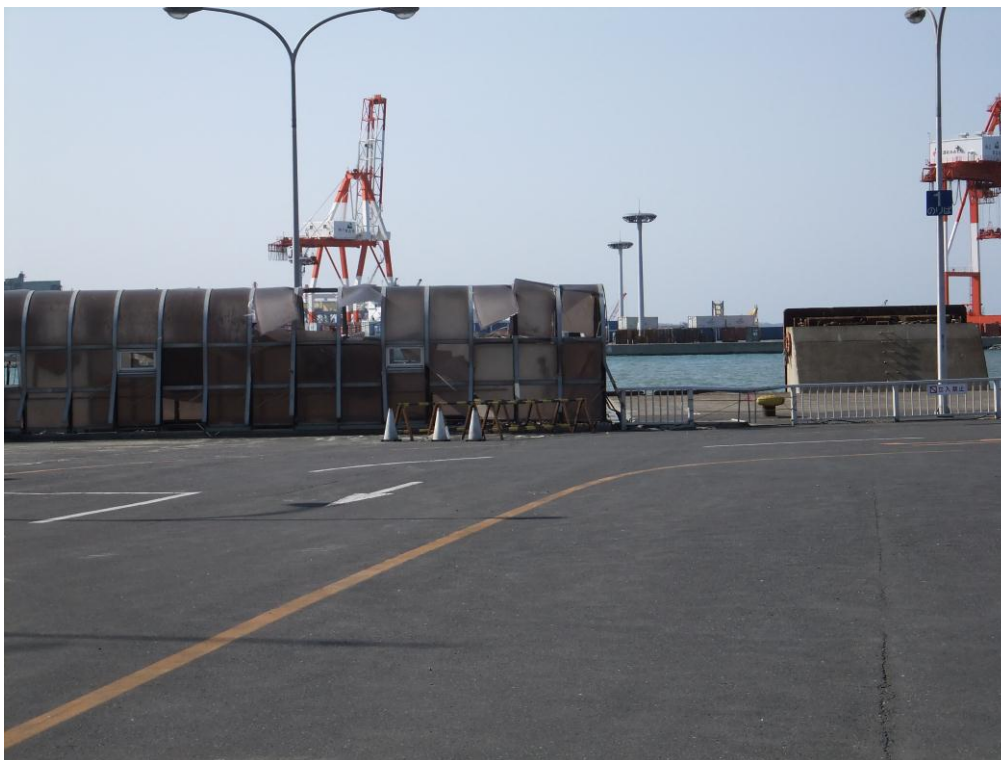
八太郎地区 フェリーふ頭 被災をうけたフェリー岸壁
