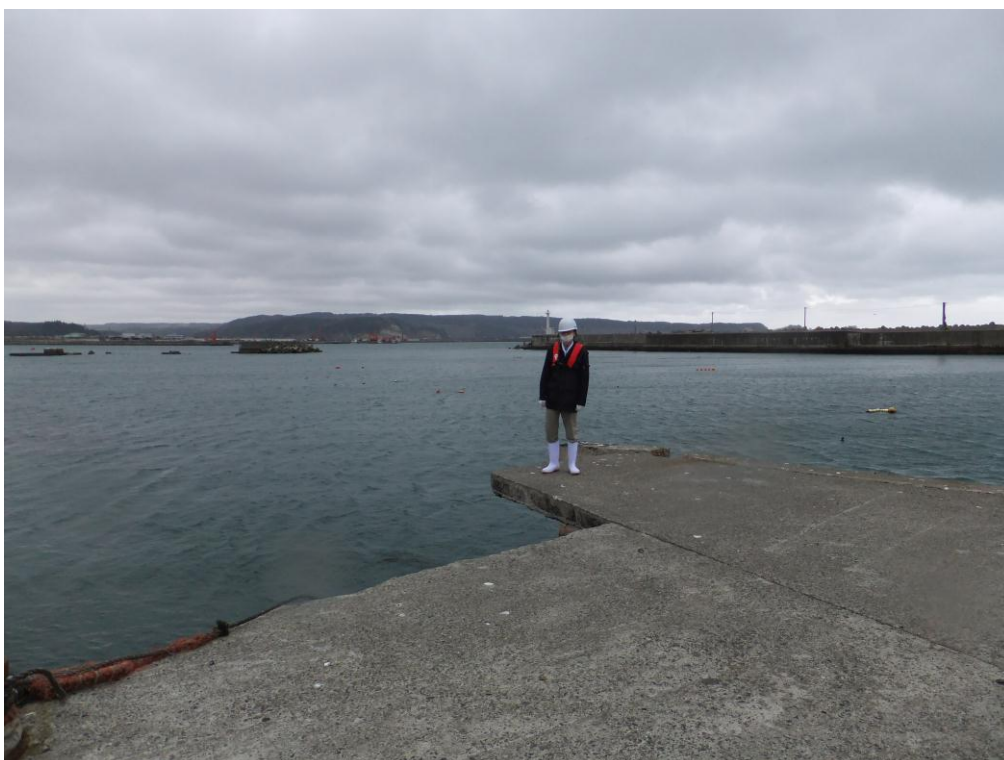
コンクリート舗装版（下がえぐれている）
