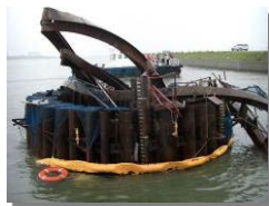
施工中の事故例
