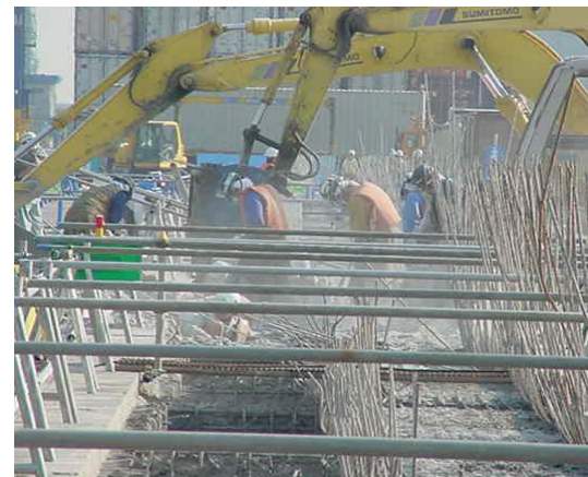
▲ 床版の打ち替え
