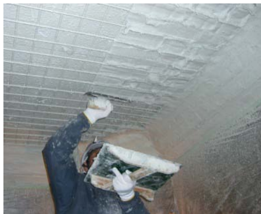
▲ 増厚工法による補強
