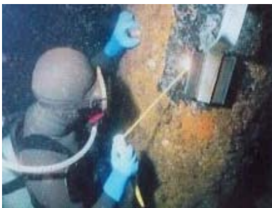
▲ 水中溶接による電気防食の施工
