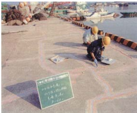
▲ エプロンのひび割れに樹脂を充填
