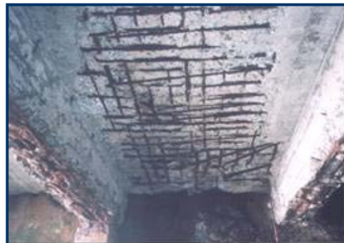
鉄筋の腐食によるコンクリートの剥離
