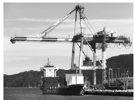
ガントリークレーン
