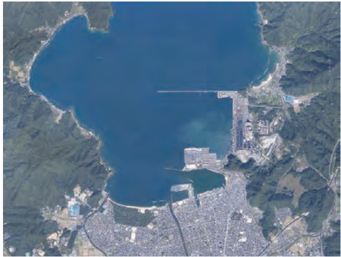
国土交通省北陸地方整備局敦賀港湾事務所提供
