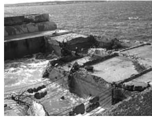
冬期風浪により被災した防波堤(青森県 むつ小川原港)
