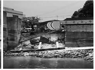
地震により被災した護岸(熊本県 合津港海岸)
