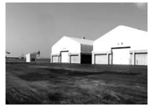
汚染土壌等保管施設
