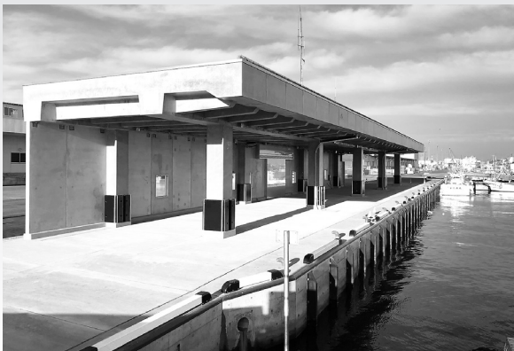
屋根付岸壁（第1期）の整備状況
