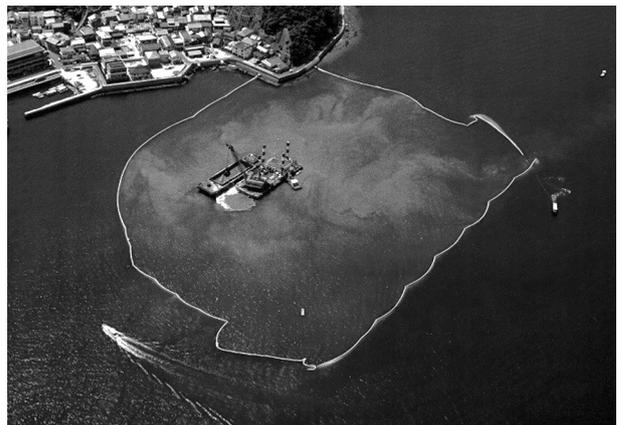
浚渫作業における汚濁防止膜の使用状況(浚渫による汚濁の拡散を防いでいる)
