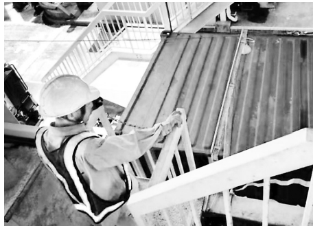
図2 コンテナ上部のチェック
