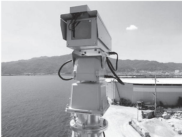
図1 直轄施工管理用のみなとカメラの例（呉港）
