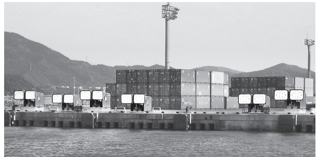
写真2 敦賀港に設置された自動係留装置
