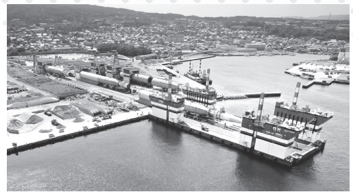
図2 浮体の浜出し（福江港） （写真提供：戸田建設（株）、R4.10月撮影）
