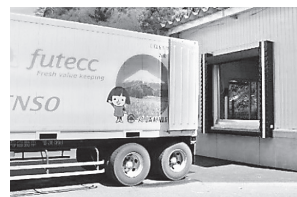
ドックシェルター整備
