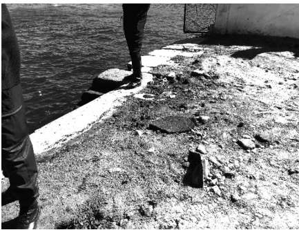
図4 土がむき出しとなったエプロン
