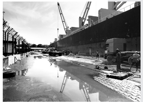
図6 埠頭にできた水溜まり
