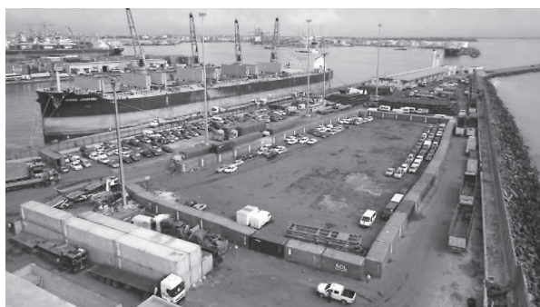
写真1 工事着工前の埠頭全景
