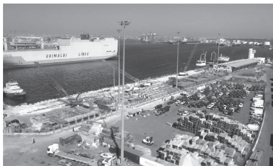
写真2 2019年11時点工事全景(手前の岸壁が施工中で、その右手側の岸壁は未施工で供用中)
