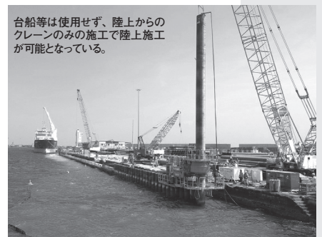
写真3 回転圧入工法による鋼管杭打設状況
