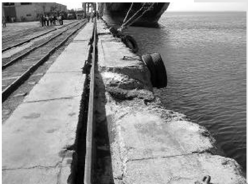
老朽化し、早急のリハビリが必要な岸壁(ナミベ港)
