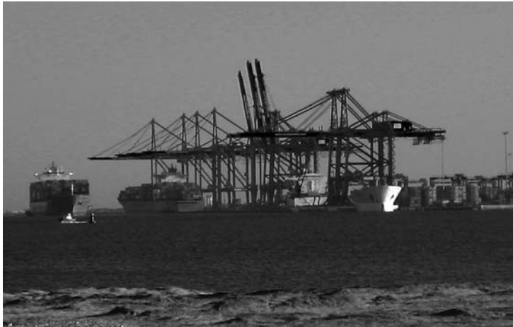
欧州向けアジア向けのコンテナ船で賑わうターミナル（SCCTサイトより）
