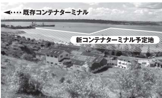
陸上から見た新コンテナターミナル建設予定地
