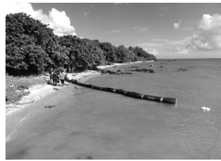
写真5 砂浜からのオイルフェンス展張訓練
