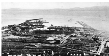
写真1 1898年の港拡張工事（写真中央部は既に開発されていた港湾）
