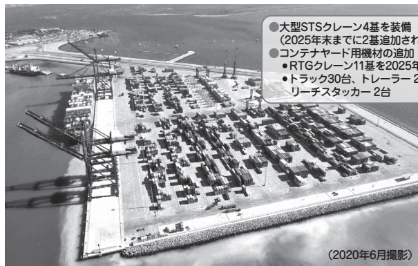
写真2 ウォルビスベイ港コンテナターミナル 出所：Namport提供
