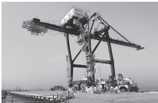
免震構造のガントリークレーン
