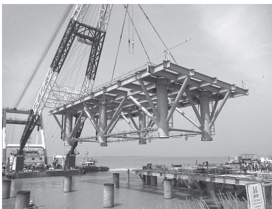
ジャケット (250t) 据付の状況
