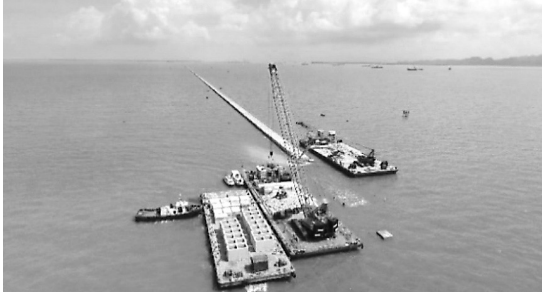
図4 防砂堤工事状況
