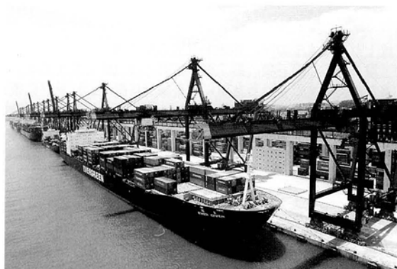
パシール・パンジャン・ターミナルの全景
