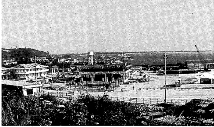
ダナン港コンテナターミナルの工事状況
