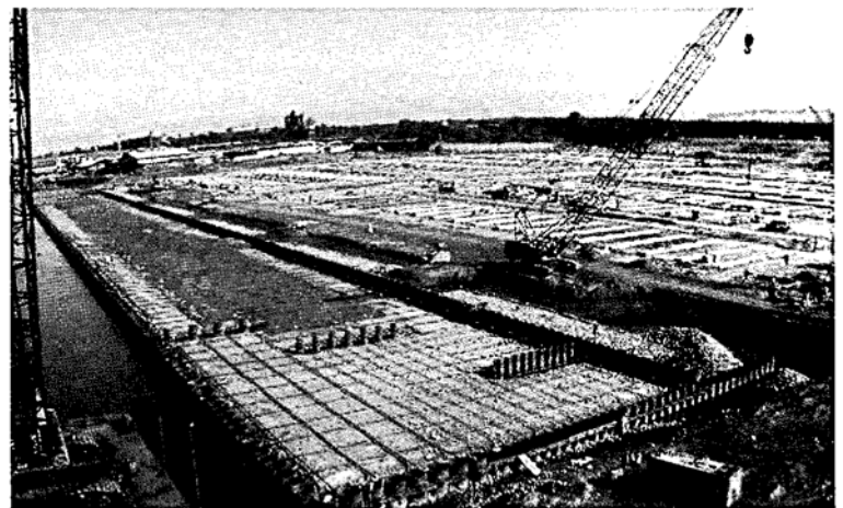
写真2 ミンダナオ/カガヤンデオロ コンテナ埠頭建設
