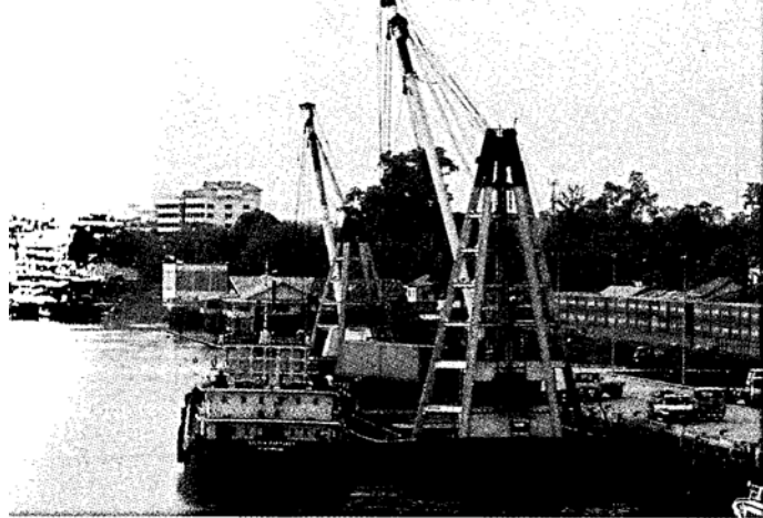
ギアつきバージによるコンテナ荷役 (プノンベン港)
