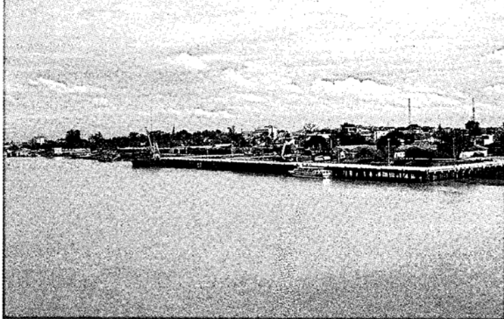
プノンベン港の全景
