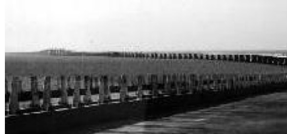
東海大橋は正に貫通したばかりで大部分の区間が未舗装、防護柵も未設置の状況であった
