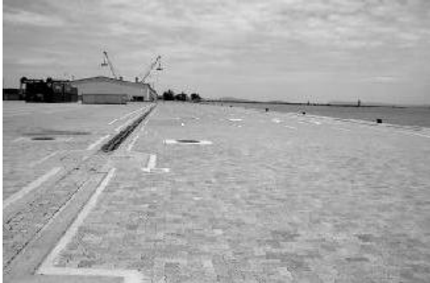
完成した円借款第1期工事
