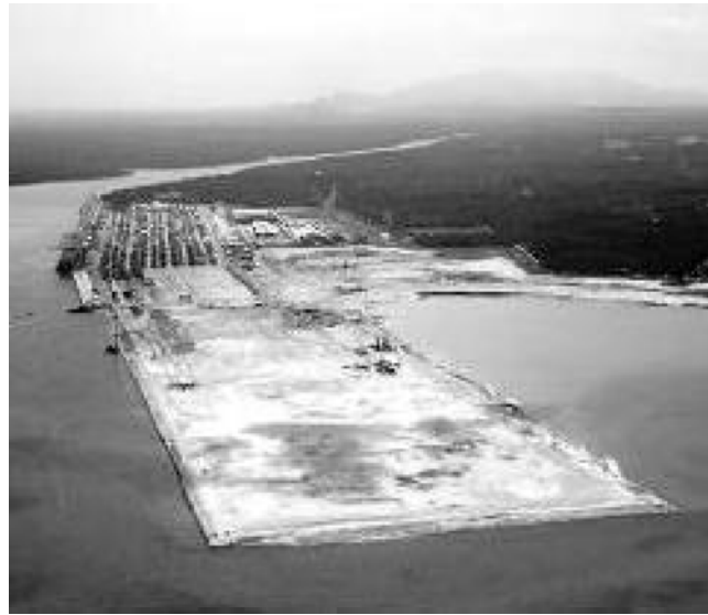
第二期拡張工事
