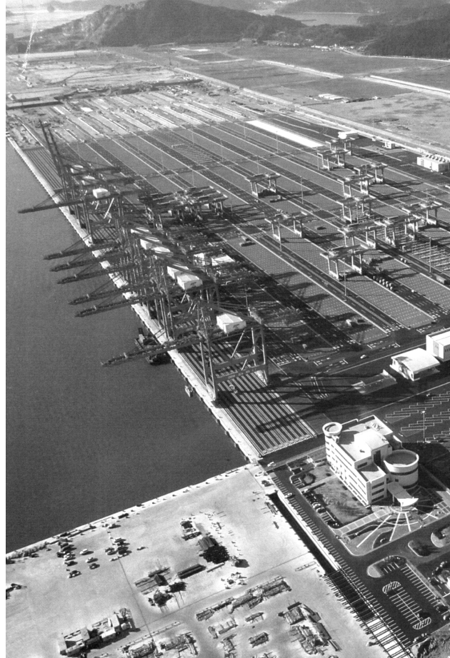
本年1月に完成した釜山新港コンテナターミナル第1期 (右方向に広がるのが物流用地) 出典:BPA
