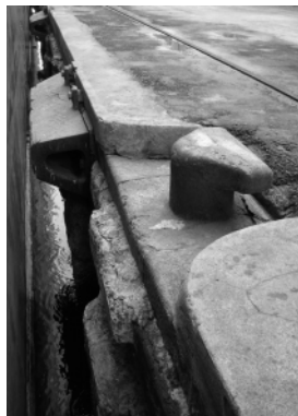
度重なるエプロン舗装の嵩上げと箱抜きされているピット
