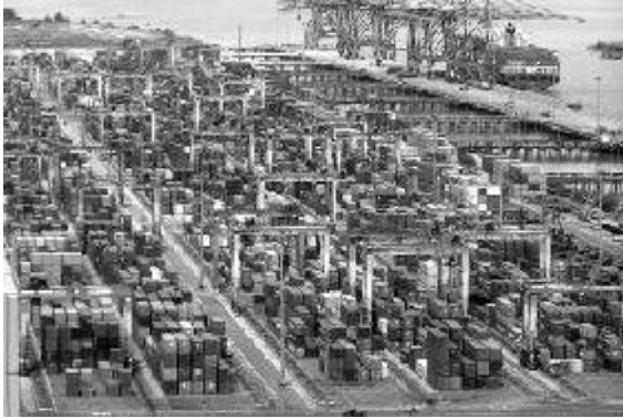
写真1 クラン港西港コンテナターミナル
