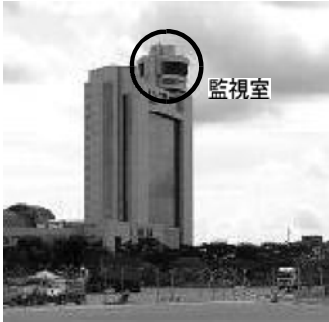
写真3 管理棟兼監視タワー
