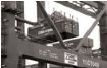
40フィートコンテナを2つ同時に扱う ガントリークレーン
