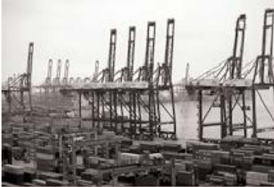
塩田地区／コンテナ・ターミナルの状況
