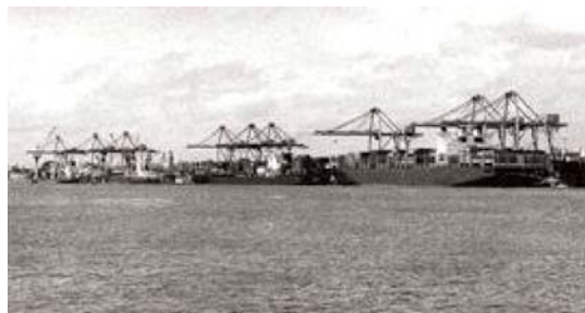
JAYAコンテナターミナル
