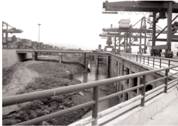
コンテナヤード（写真左側）から前面水域に張り出して整備されたコンテナ積み卸しを行う岸壁（写真右側）
