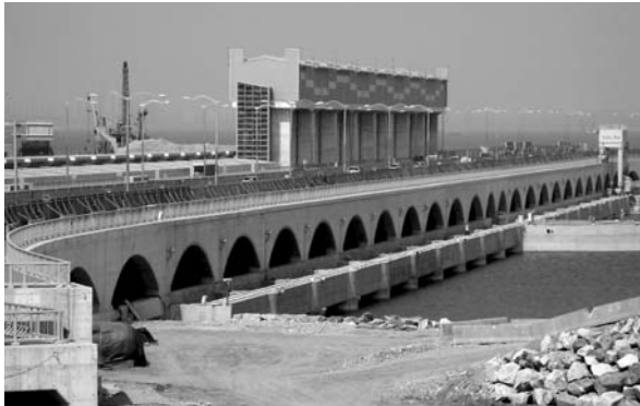
引き潮時に開放される水門(中央)と発電サイト(左)
