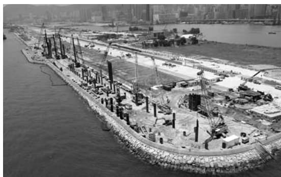
写真2 鋼管杭打設
