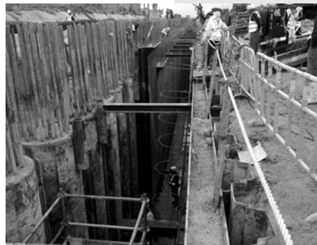
写真3 フロントパネル施工
