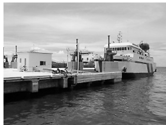
写真2 デイリ港フェリーターミナル 日本の無償資金協力で整備。RoRoフェリーが2隻同時に着岸することができる。 出典：筆者撮影
