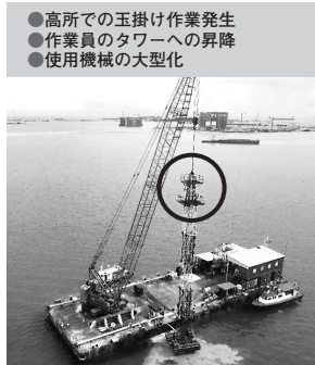
写真1 CPTタワー (従来工法) とその問題点
