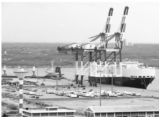
Ro-Ro船接岸（撮影：2019年2月）
