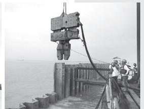
写真6 鋼矢板打設指導
