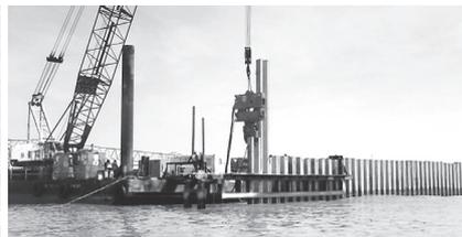
写真5 鋼矢板打設
