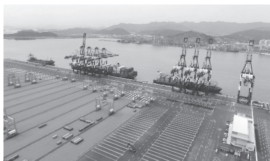
2022年4月から供用開始された釜山新港6埠頭（2-4段階） 写真提供：釜山コンテナターミナル（BCT）
