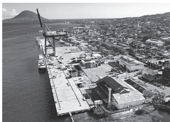
写真2 テルナテ港現況写真（2023年5月OCDI撮影）
