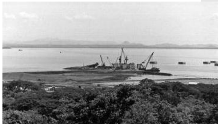
仮設栈橋に係留したFDでのケーソン製作（沖合いに完成函に係留）
