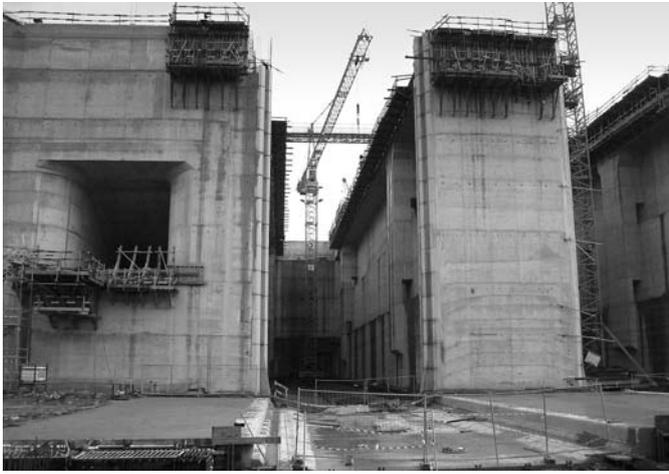
写真1 二重の鋼製ゲートのピット部分 (写真中央と右) 左の開口部は閘門内外の水位を等しくするための水の出入り口 (筆者撮影)
